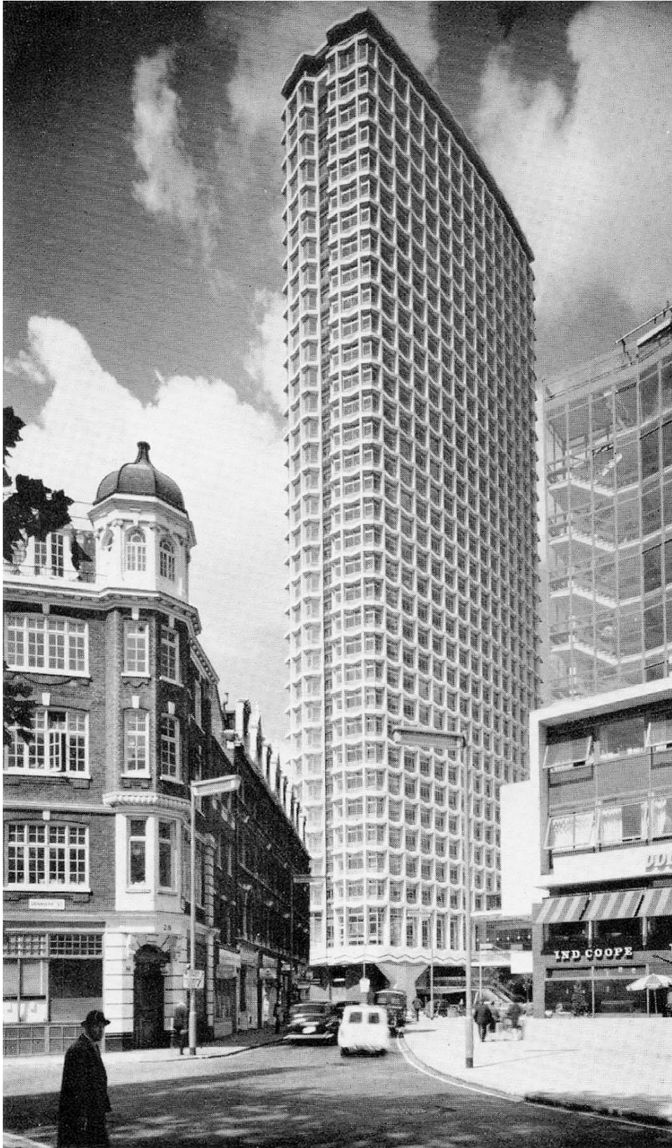
Figure 5 : Centre Point , 1965. Source : LMA
